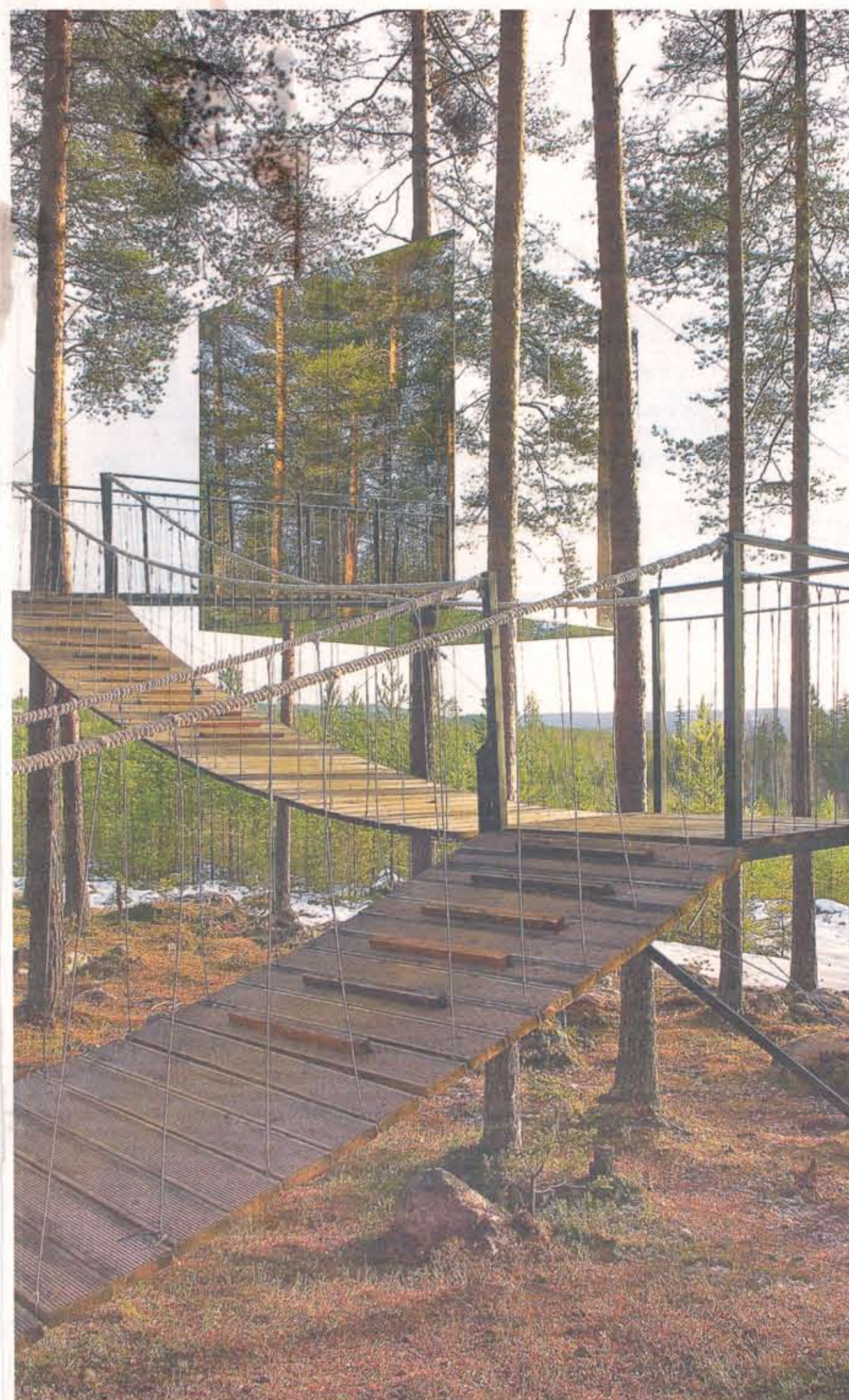
En infraröd film på fasaden på Spegelkuben påverkar fåglarna så att de inte flyger in i byggnadens spegelväggar. FOTO: NIKLAS INGSTEDT
